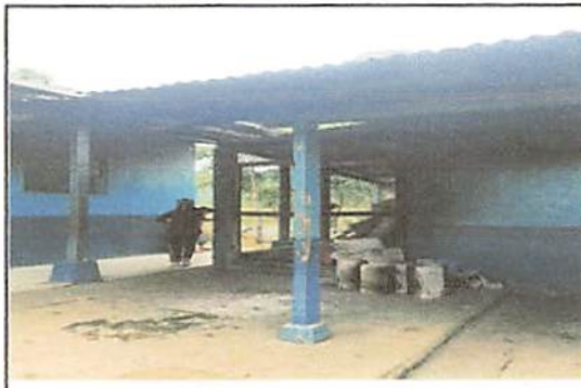
Foto 2: cocina cambiar el piso y corredor cambio de laminas
