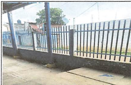
Foto 4: Area de adentro pintar paredes y aulas
