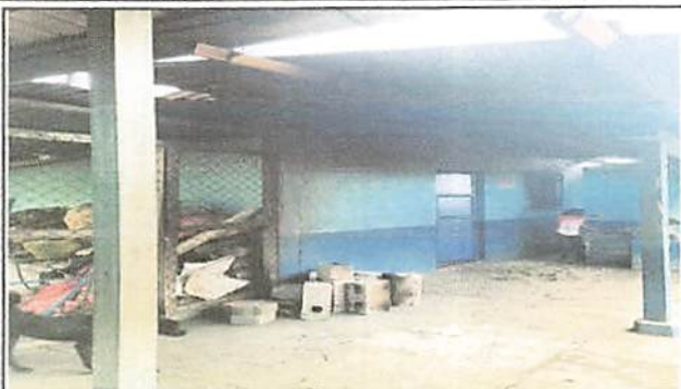
Foto1: Cocina remodelar parales y techo
