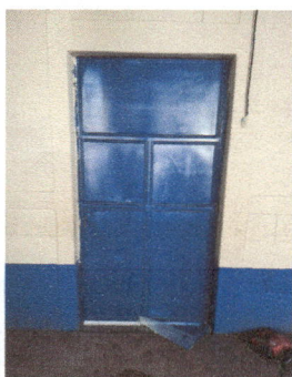
Foto 5: mantenimiento de puertas de los salones de clase
