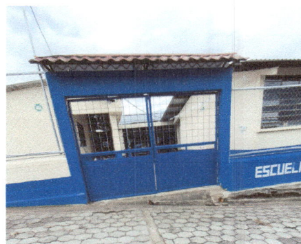
Foto 4: finalizacion de mantenimietni de portón principal
