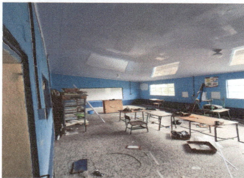
Foto1: Colocacion de cielo falso, en Salón de computacion, direccion y salón de segundo primaria
