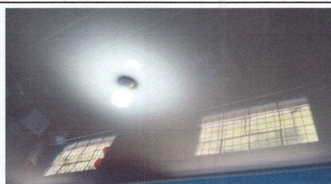
Foto 6: colocación de cielo falso
