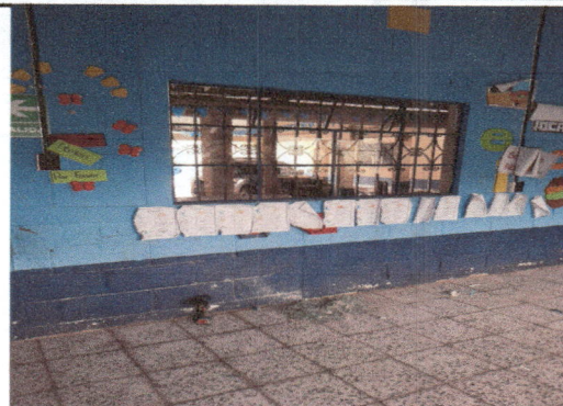
Foto 2: finalizacion de piso de granito
