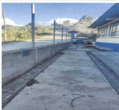
Foto 9 cambio de tubos galvanizados ya instalados y cambio de malla de la circulación de la parte de enfrente
