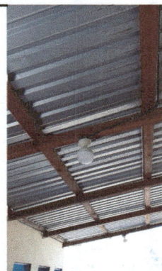
Foto 8 se instaló la energia electrica en el corredor de los sanitarios
