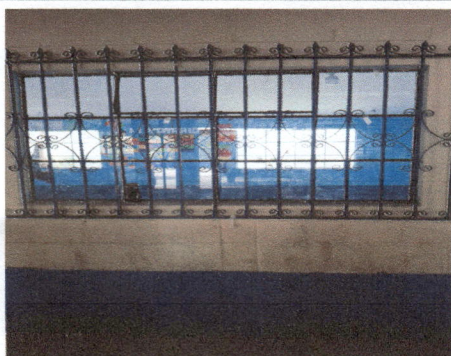
Foto 7: se cambio vidrios en las ventanas que estaban quebradas
