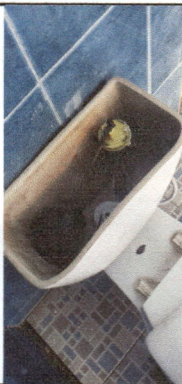
Foto 3: se cambio los kits de los 4 sanitarios
