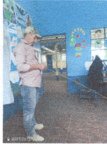
Foto1: El albañil mide el espacio para iniciar a colocar el piso.
