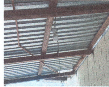
Foto 2: El electricista ya empieza a desmontar toda electricidad en mal estado.
