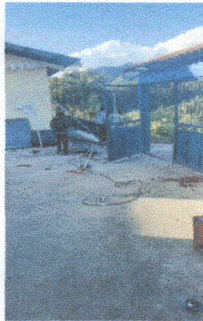
Foto 3: El personal de herrería inicia con desmontar los tubos en mal estado e inicia colocando los nuevos, en conjunto de la nueva malla galvanizada.
