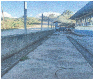
Foto 5: Todos los tubos nuevos ya instalados.
