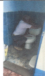
Foto 4: El albañil inicia con la instalación de los kits de accesorios de los inodoros.
