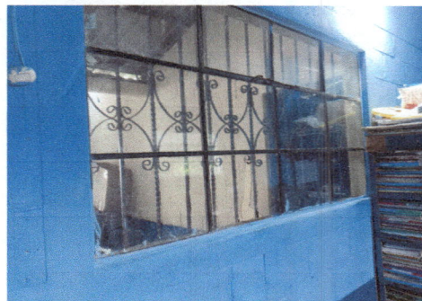
Foto 2: Se necesita cambios de vidrios en las ventanas ya que se encuentran quebradas.
