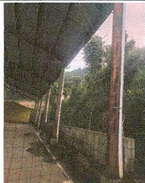
Foto 1: Bajadas de agua pluvial
