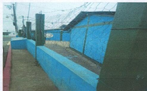
Foto2: Reglón No.15 Cerca o muro perimetral
