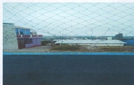
Foto 4: Reglón No. 15 Cerco o muro perimetral
