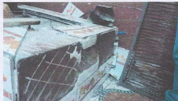
Foto 2: sustitución de azulejos y piso de la cocina
