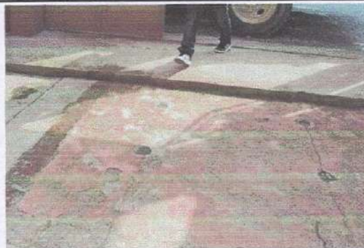
Foto 2: colocación de Losa de patio
