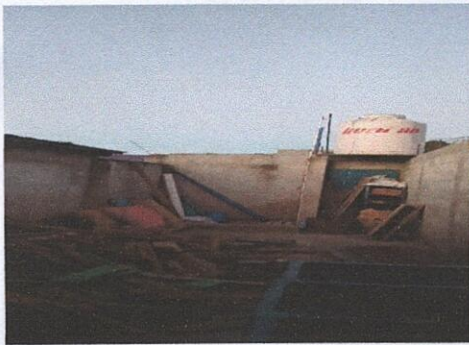
ESTRUCTURA DE TECHO SOBRE UNA BODEGA SIN TECHO
