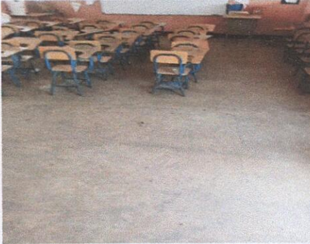
SUSTITUCIÓN PISO TORTA DE CONCRETO A PISO CERAMICO
