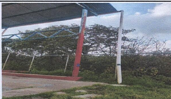
Foto 6: En otra parte del techado, las bajadas de agua ya estan en mal estado, por lo tanto no realizan el trabajo necesario
