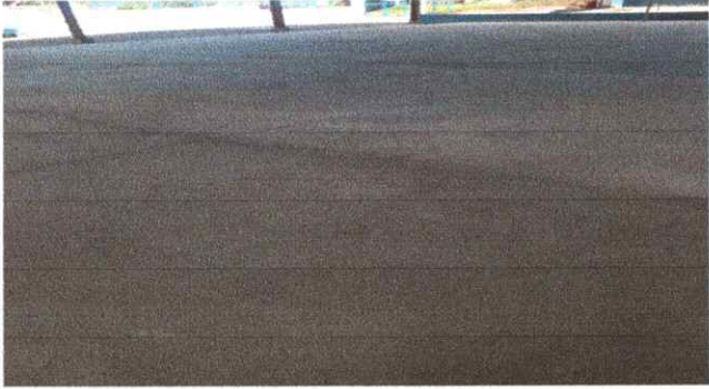
Foto 1: Finalización del trabajo, fundición de losa.
