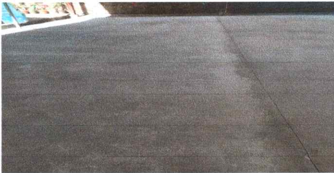
Foto 3: Finalización del trabajo, fundición de losa.
