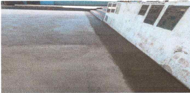
Foto 5: Finalización del trabajo, fundición de losa.
