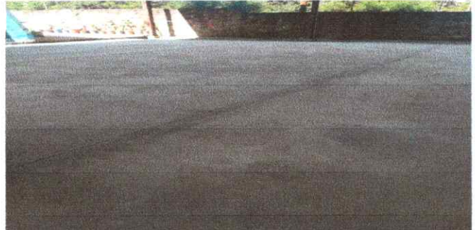
Foto 6: Finalización del trabajo, fundición de losa.
