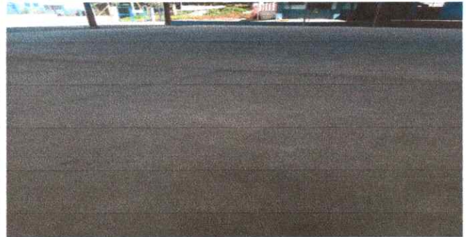
Foto 4: Finalización del trabajo, fundición de losa.
