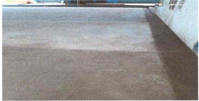
Foto 2: Finalización del trabajo, fundición de losa.
