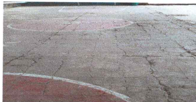
Foto 6: Fundición de losa "Pavimento en mal estado, necesario su reposición".
