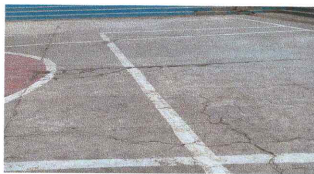
Foto 2: Fundición de losa "Pavimento en mal estado, necesario su reposición".
