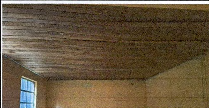
Foto 6: Falta de energía eléctrica
