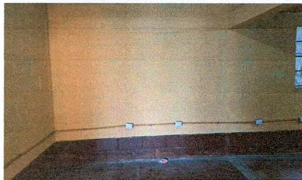
Foto 2: Espacio para construir gabinetes fundidos
