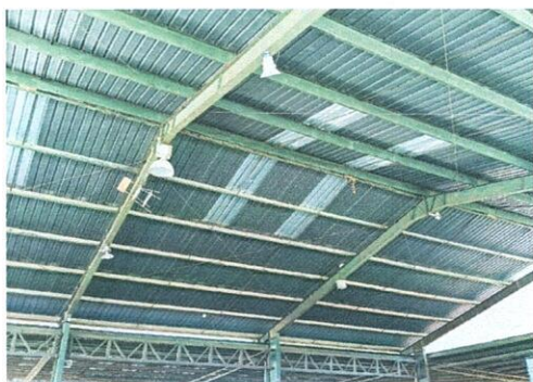
Foto 5: Colocación de lámparas en la cancha polideportiva.
