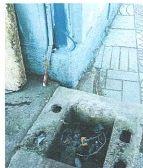
Foto 6: Cambio de cables para las cajas de registro de distribución de energía.
