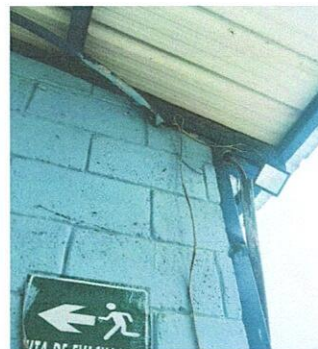
Foto 2: Instalación de cajas de registro de cada módulo de dos aulas cada uno y de la energía del escenario.
