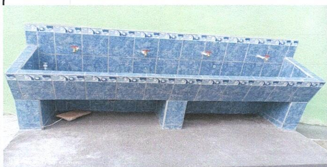
Foto 3: Instalación de piso cerámico y azulejos en los sanitarios.
