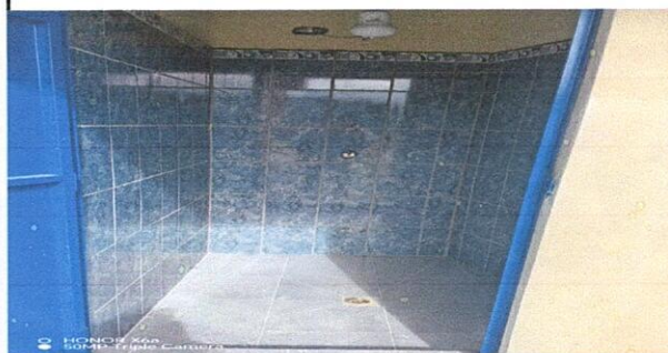
Foto 4: Demolición de muro y levantado del muro, es ese lugar se instaló un área de ducha
