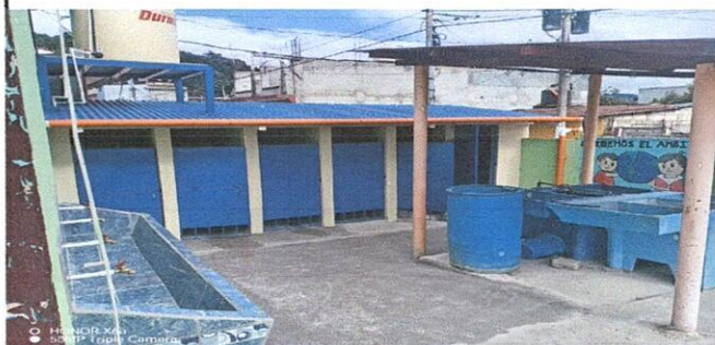
Foto1: Remodelación e instalación de puertas. Instalación de tináco y de lavamanos de cemento y azulejo en los sanitarios.
