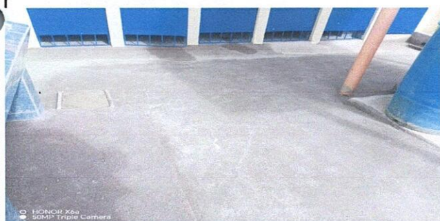
Foto 5: Remodelación de piso de concreto
