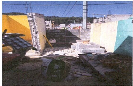
Foto 4: Demolición de muro y levantado del muro
