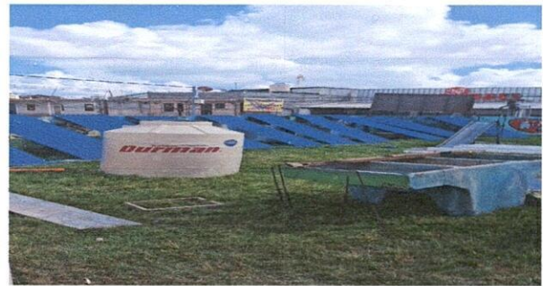
Foto 6: Remodelación, pintado e instalación de estructura metálica en el techo.
