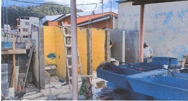
Foto1: Remodelación e instalación de puertas. Instalación de tinaco y de lavamanos de cemento y azulejo en los sanitarios.
