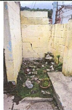
Foto 4: Demolición de muro y levantado del muro
