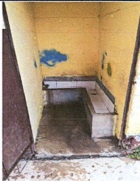
Foto 3: Instalación de piso cerámico y azulejos en los sanitarios.
