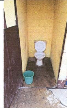
Foto 2: Remodelación e instalación de sanitarios
