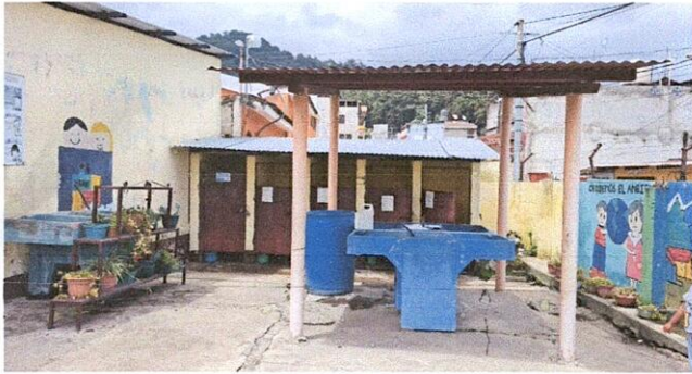
Foto1: Remodelación e instalación de puertas. Instalación de tináco y de lavamanos de cemento y azulejo en los sanitarios.
