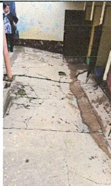
Foto 5: Remodelación de piso de concreto
