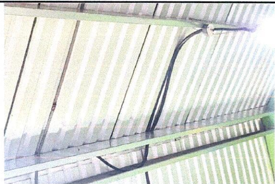
Foto 1: Se corrigieron los traslapes de las láminas, además se les colocó adhesivo para asegurar aún más que no se tenga filtraciones.
