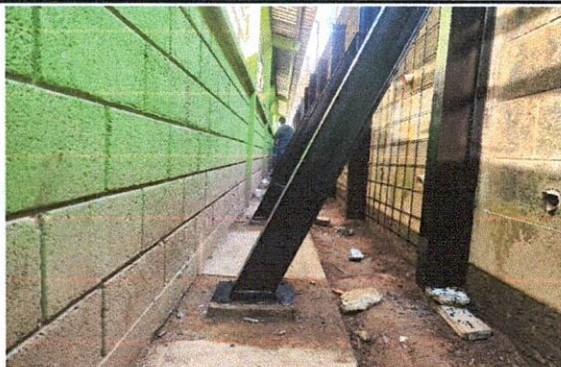
Foto 3: La instalación de vigas de molino garantiza a que el muro de contención no se derrumbe.
