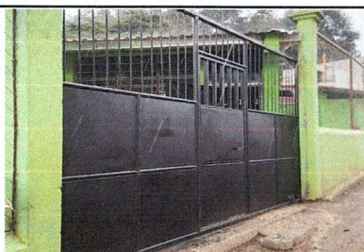
Foto 6: Se eliminaron elementos peligros del portón, y se le aplicó pintura para darle protección.
