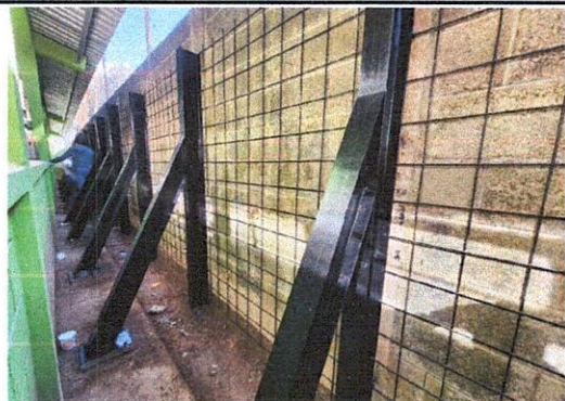
Foto 1: El muro de contención es sujetado con vigas de molino que tienen bases de cemento con columnas de hierro.
