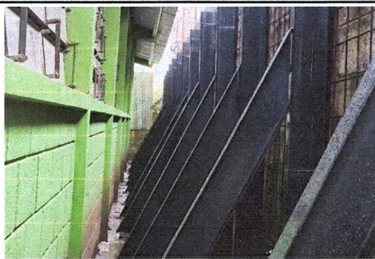
Foto 2: El muro de contención queda reforzado y seguro con 13 vigas, eliminando riesgos para la infraestructura y sobre todo para los alumnos.
