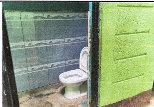
Foto 3: Los sanitarios fueron cambiados por unos más pequeños y se instaló azulejo e iluminación.
