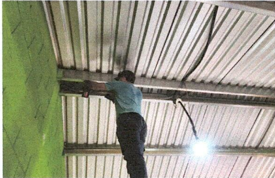
Foto1: Se corrigen los malos traslapes de las láminas y se acomodaron nuevamente.
