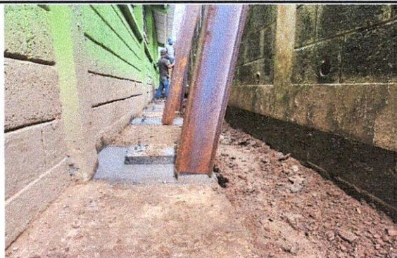
Foto 3: La instalación de vigas previene y garantiza que la humedad del suelo no ponga en riesgo los salones de clases a que el muro de contención se caiga.
