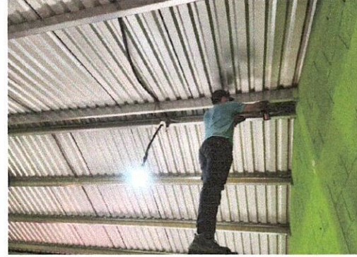
Foto 2: Se les colocó remaches a las láminas para evitar que queden con aberturas.
