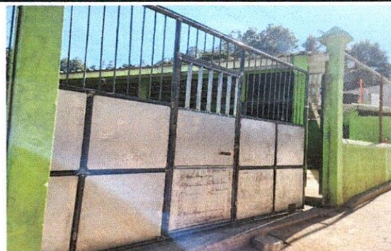
Foto 6: Se cambió la malla, se cambió la lámina tradicional por una gruesa acorde al portón.
