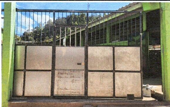
Foto 5: El portón fue remodelado ya que estaba muy dañado, se quitó la lámina peligrosa, y se colocó una puerta pequeña.
