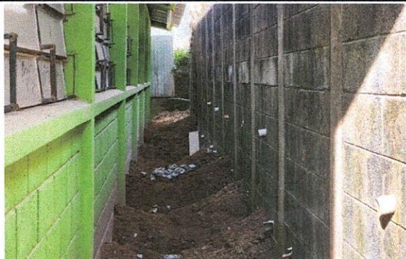
Foto 1: Elaboración de bases para las vigas de molino que harán el contrapeso para el muro dañado.
