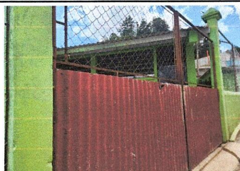
Foto 6: Requiere cambio de malla, lámina de metal segura y pintura.
