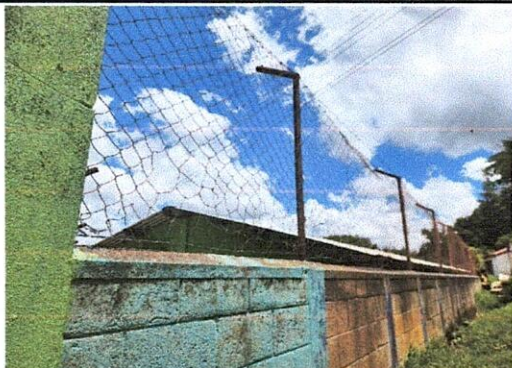
Foto 1: La malla de la circulación está deteriorada, tiene más de 25 años. Requiere cambio de malla.
