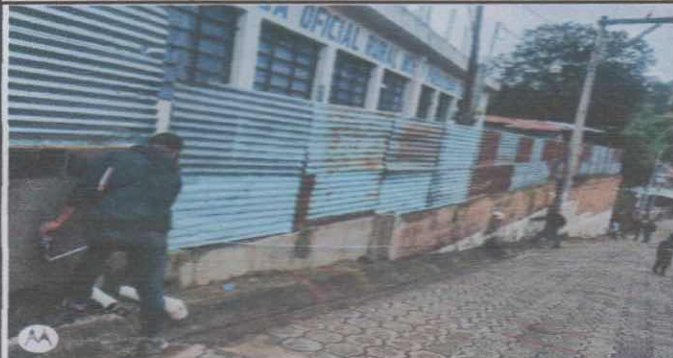
Foto1: reparacion de muro de contención
