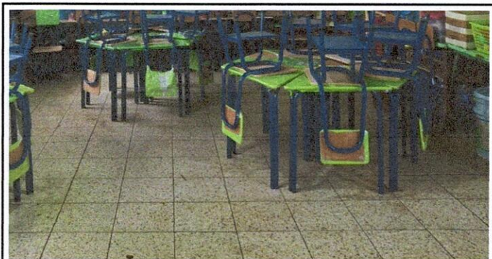
Foto6: Colocación de piso Cerámico
