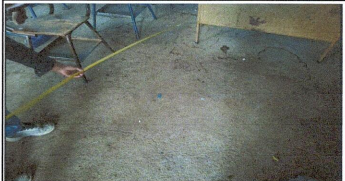
Foto 4: Colocación de piso cerámico
