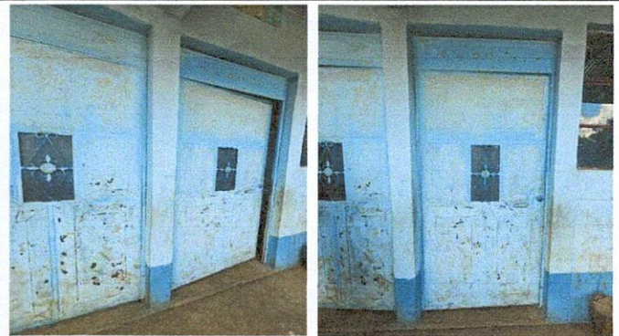
Foto 2: Sustitución de dos puertas.
