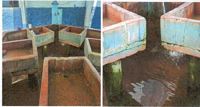
Foto1: Mantenimiento correctivo a pila con 5 lavaderos. La pila presenta grietas, los lavaderos están quebrados en muy mal estado por lo que se decide construir una nueva para darle un óptimo uso.
