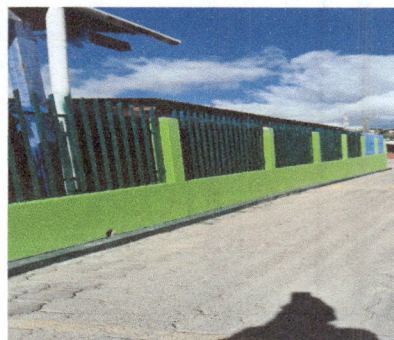
Foto 4: Pintado de barrandas, aulas y muro
