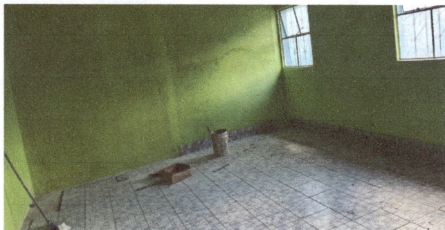
Foto1: Cambio de piso y repello
