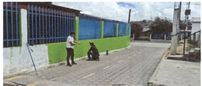
Foto 6: aplicación de pintura
