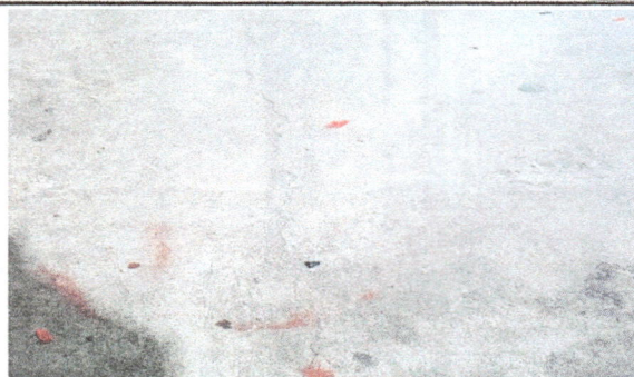
Foto 2: Cambio de piso
