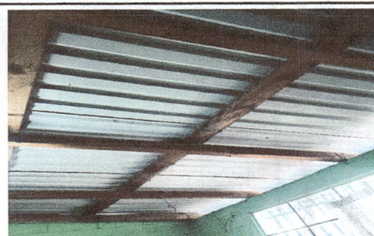
Foto 6: Cambio de lámina de salón 2
