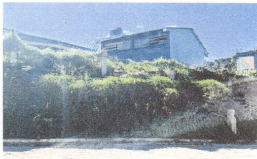
Foto 7: Reemplazo de malla, parte de la calle principal
