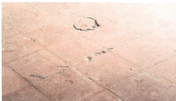
Foto1: Cambio de piso
