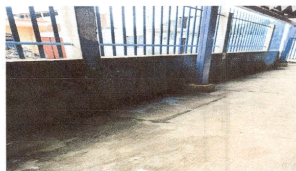
Foto 4: Pintado de barrandas, aulas y muro
