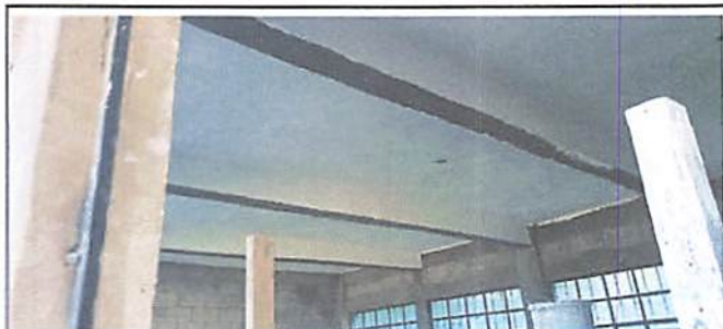
Foto 1: Aquí se puede observar que ya se empezó con el tallado de techo y vigas.
