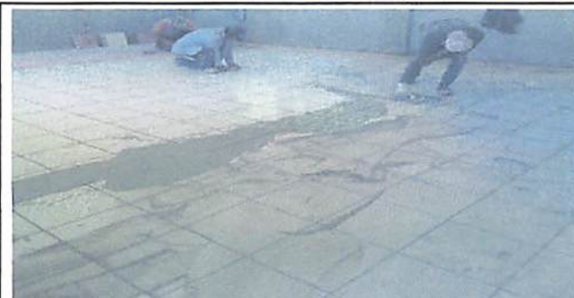
Foto 6: Se está colocando la sisa para asegurar el pegado del piso.
