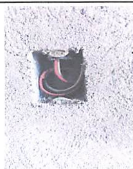
Foto 2: Ya está en proceso la instalación de la energía eléctrica.
