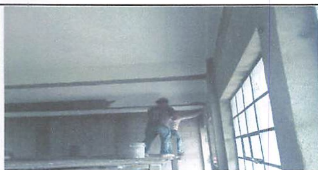
Foto 3: Ya se empezó con el repello en las paredes.
