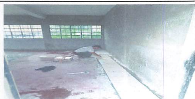
Foto 5: Se empieza con la colocación del piso en los salones.
