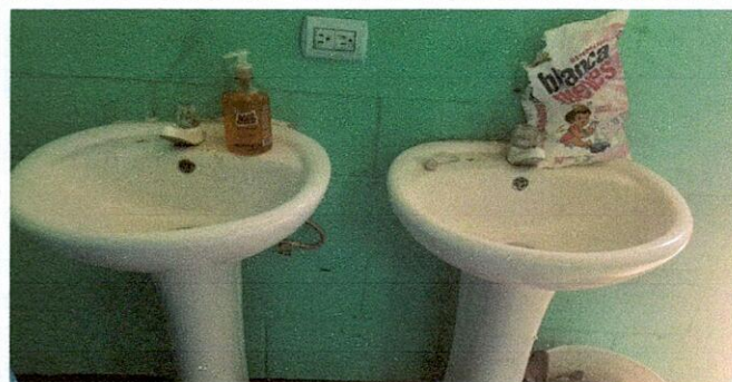
Foto 2: reparación de lavamanos de sanitarios de hombres y mujeres
