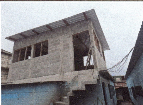
Foto 7: HILADAS DE BLOCK Y TECHADO
