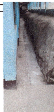
Foto 4: DESFOGUE DE AGUA PLUVIAL
