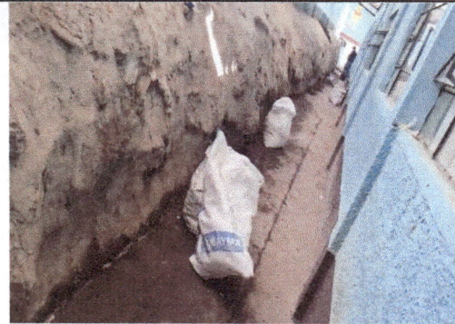
Foto 4: DESFOGUE DE AGUA PLUVIAL
