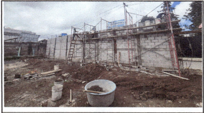
FOTO 2 CONSTRUIR NUEVO MURO PERIMETRAL
