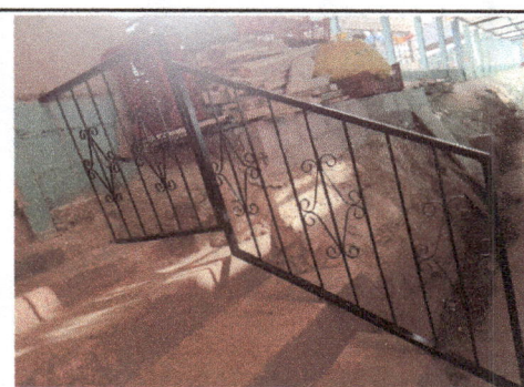
Foto 6: INSTALACIÓN DE BARANDA
