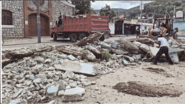
Foto1: BOTAR MURO PERIMETRAL
