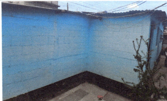
FOTO 9: LEVANTADO DE 5 HILADAS DE BLOCK Y TECHADO DE SALON
