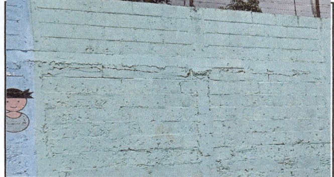
FOTO 2 CONSTRUIR NUEVO MURO PERIMETRAL
