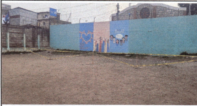
Foto1: BOTAR MURO PERIMETRAL
