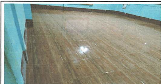
Foto 3: Salón 3, Con piso y zócalo
