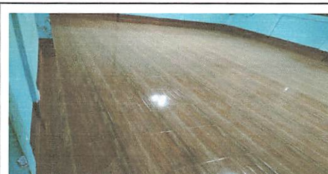
Foto 4: Salón 4, Con piso y zócalo
