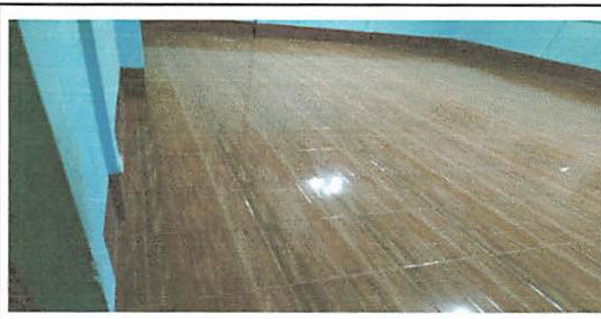
Foto 6: Salón 6, Con piso
