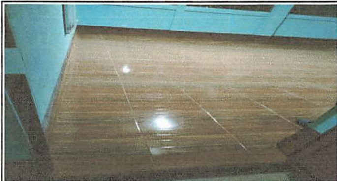
Foto 1: Salón 1, Con piso y zócalo
