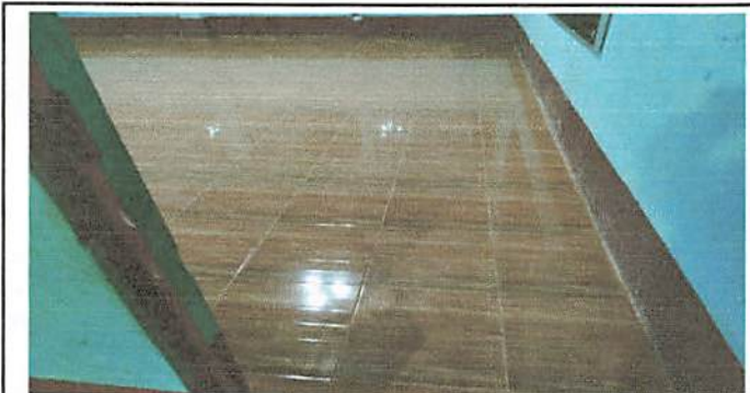
Foto 5: Salón 5, Con piso
