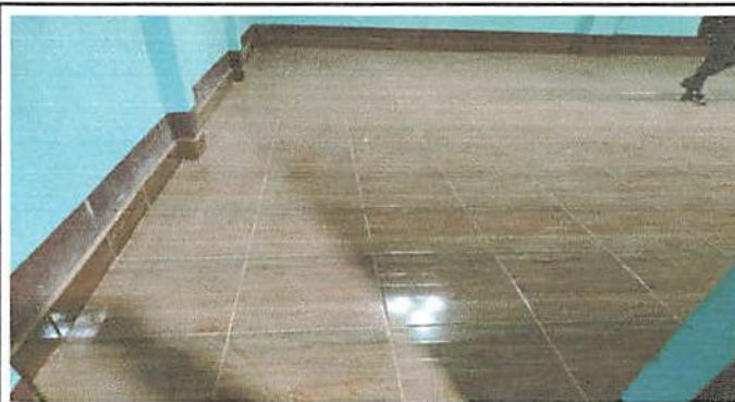
Foto 2: Salón 2, Con piso y zócalo
