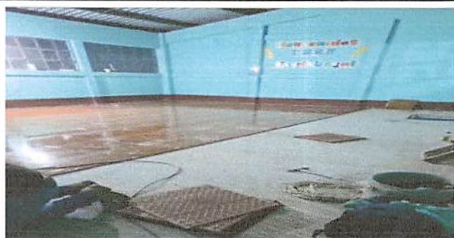
Foto 5: Colocación de piso en salones 4, 5 y 6
