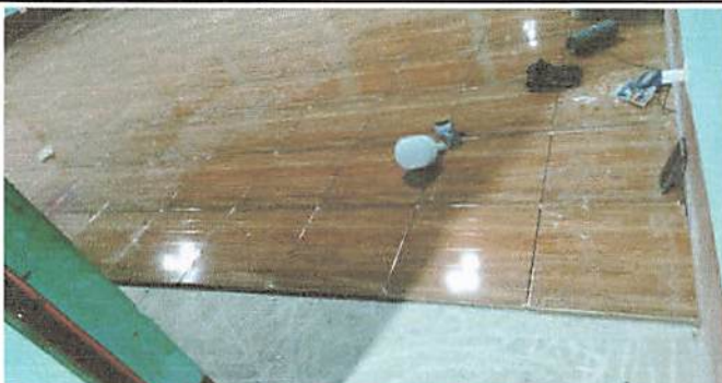
Foto 4: Inicio de colocación de piso en salones 4, 5 y 6
