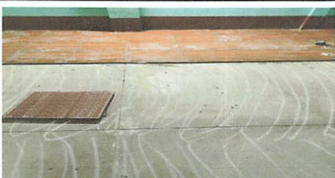
Foto 3: Inicio de colocación de piso en salones 1, 2 y 3
