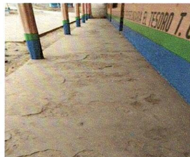
Foto 2: PISO PARA PARA 4 SALONES Y EL CORREDOR PRINCIPAL
