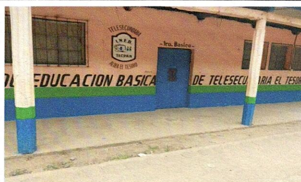
Foto 4: CAMBIO DE 4 PUERTAS
