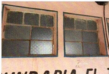
Foto1: CAMBIO DE VENTANAS , PARA 4 SALONES DE CLASES
