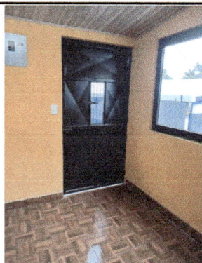
Foto 3: Vista interior de la puerta, piso, flipones en ampliación de cocina
