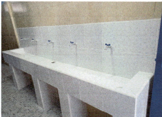
Foto 7: lavamanos en remodelacion de sanitarios
