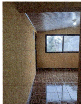
Foto 2: Pisto interior, cielo falso y ventanal de la ampliación de cocina
