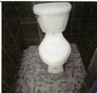
Foto 5: Colocación de sanitarios/inodoros
