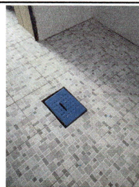
Foto 4: Remodelación de drenaje de sanitarios
