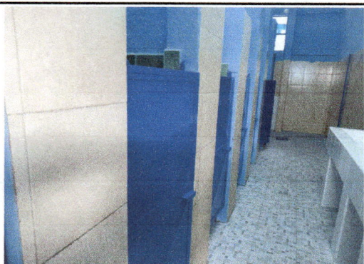
Foto 3: Pintado de puertas y remodelacion de piso en los sanitarios
