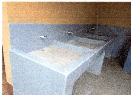
Foto 4: Vista final del lavatrastos de la ampliación de cocina
