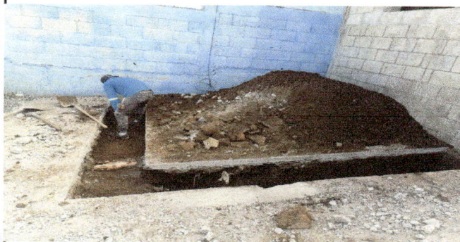
Foto1: Trazo y excavación de zanja para ampliación de cocina
