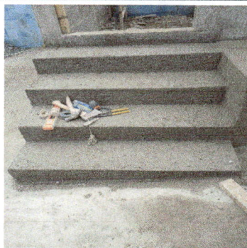
Foto 5: Fundición de gradas en la ampliación de cocina
