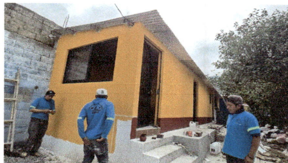
Foto 12: Pintado de paredes de la ampliación de cocina
