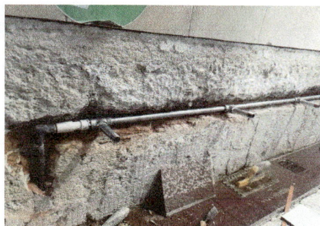
Foto 17: Desmontaje de azulejo y colocacion de chorros en lavamanos en sanitarios
