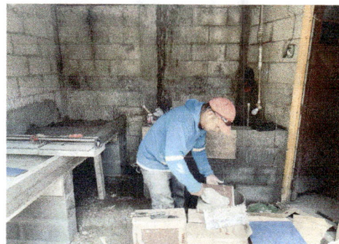
Foto 22: instalación de azulejo en lavastratos y pila en ampliación de cocina
