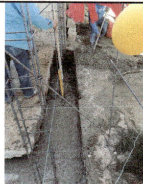
Foto 2: Fundición de cimiento de ampliación de cocina
