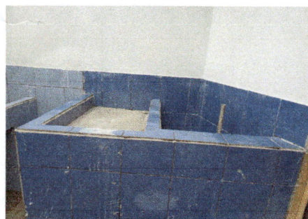
Foto 23: Colocación boquille en azulejo de la pila de en la ampliacion de cocina
