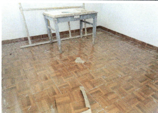
Foto 9: Colocación de piso en la ampliacion de cocina
