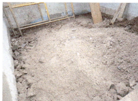
Foto 6: Colocación de selecto y fundición de contrapiso de la ampliación de cocina
