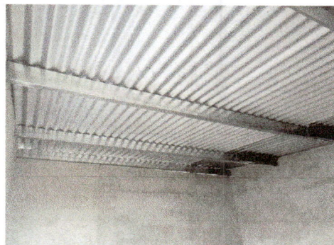
Foto 8: Láminas en el techado de la ampliación de cocina
