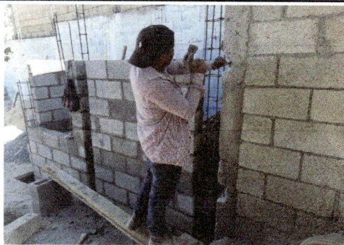
Foto 3: Levantado de muro de dos pares de la ampliación de cocina
