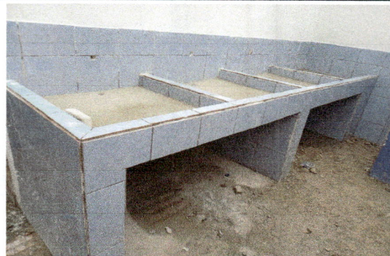
Foto 20: Colocacion de azulejo en lavatrastos de la ampliación de cocina
