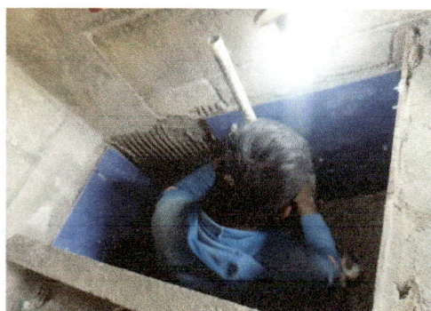
Foto 21: instalacion de agua en la pila de la ampliacion de cocina
