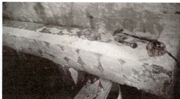
Foto13: Desmontado de azulejo en migitorios en sanitarios
