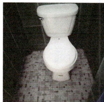
Foto 16: Colocacion de inodoros nuevos en los sanitarios
