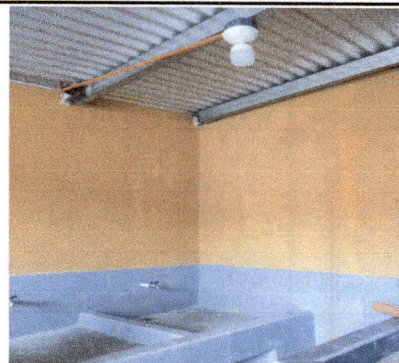
Foto 24: Instalacion de techado de la pila y lavastratos de la ampliación de cocina
