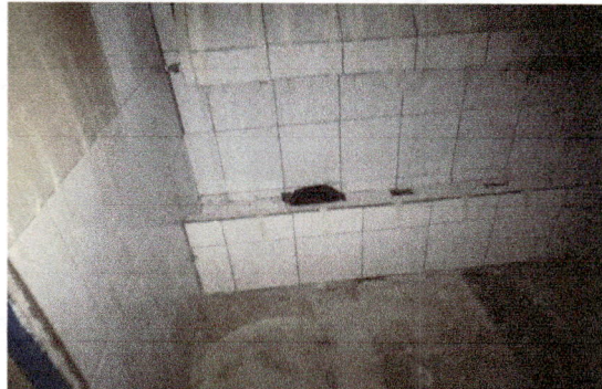
Foto 14: remodelacion de drenaje y colocacion de azulejo en migitorio de sanitarios
