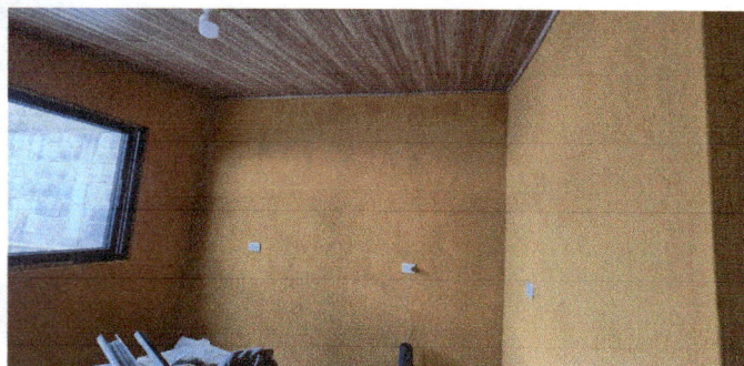
Foto 11: Instalación de cielo falso en la ampliación de cocina
