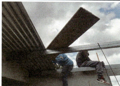
Foto7: Coacion de lámina en el techo para ampliacion de cocina
