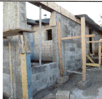
Foto 4: Finalización de paredes y fundición de solera de ampliación de cocina.
