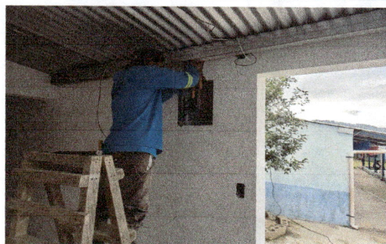
Foto 10: Instalación de la red de energía eléctrica en la ampliación de cocina
