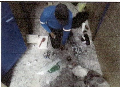
Foto 15: desmontaje de inodoros en sanitarios
