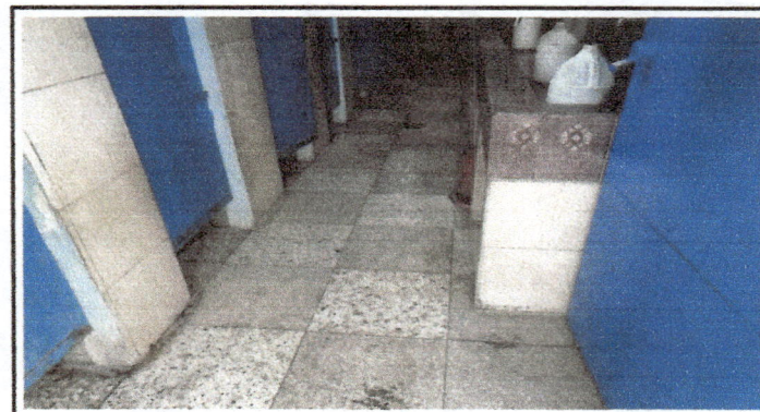
Foto 4: Remodelación y colocación de piso.
