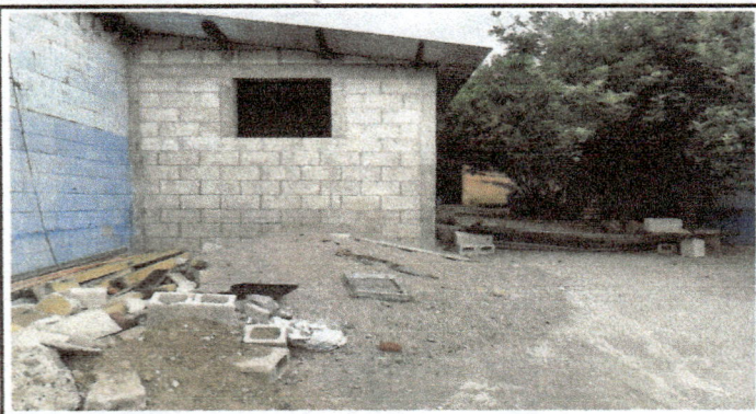
Foto 1: Remodelación, ampliación de cocina, colocación de piso azulejo, instalación eléctrica, repello de pared, puerta, ventana, estructura del techo costanera y lámina.
