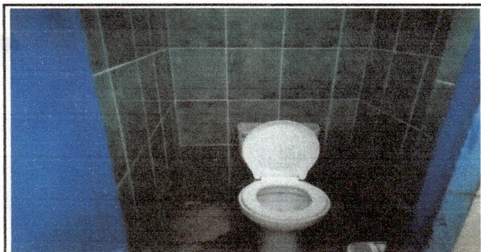
Foto 5: Remodelación e instalación de sanitarios.
