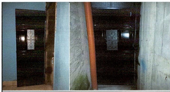
Foto 6: pintura en muros interiores y exteriores.
