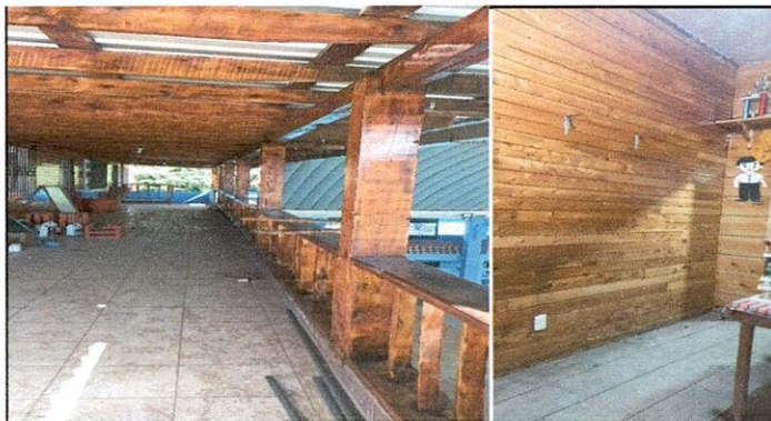
Foto 3: pintura con barniz en interior y exterior de aulas del tercer nivel.
