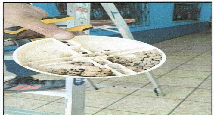
Foto 4: cambio de plafoneras.
