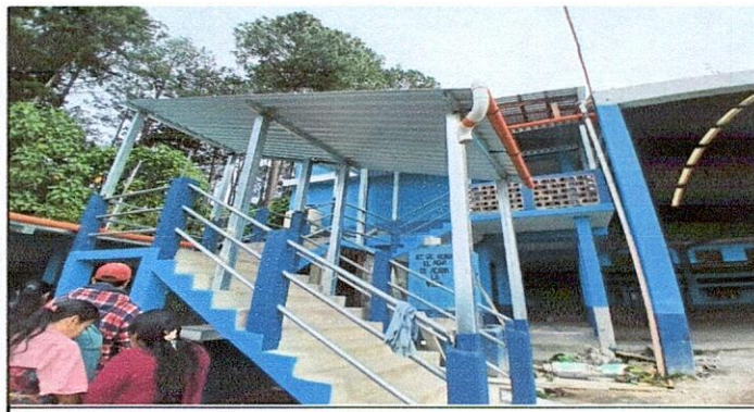
Foto 6: Estructura de techo para gradas.
