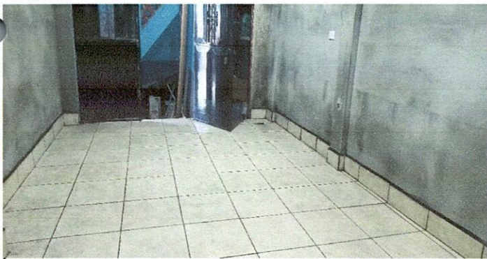
Foto 5: reparación de repello y cernido de pared y colocación de piso .
