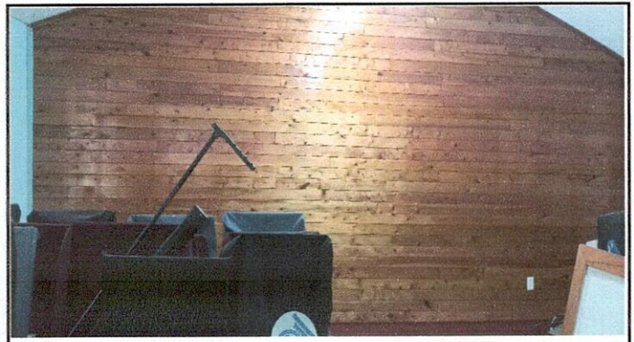
Foto 4: pintura con barniz del aulas del tercer nivel.
