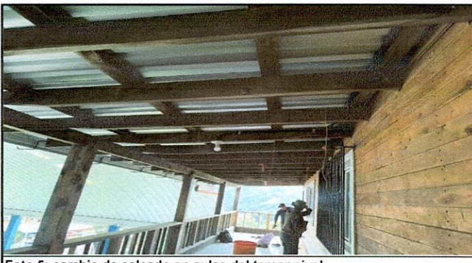
Foto 5: cambio de caleado en aulas del tercer nivel.
