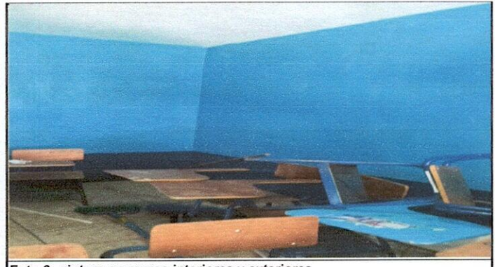
Foto 6: pintura en muros interiores y exteriores.
