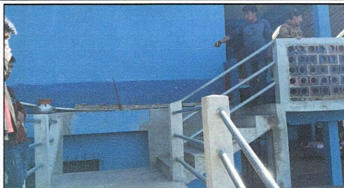
Foto 2: Implementación de estructura metálica sobre gradas.
