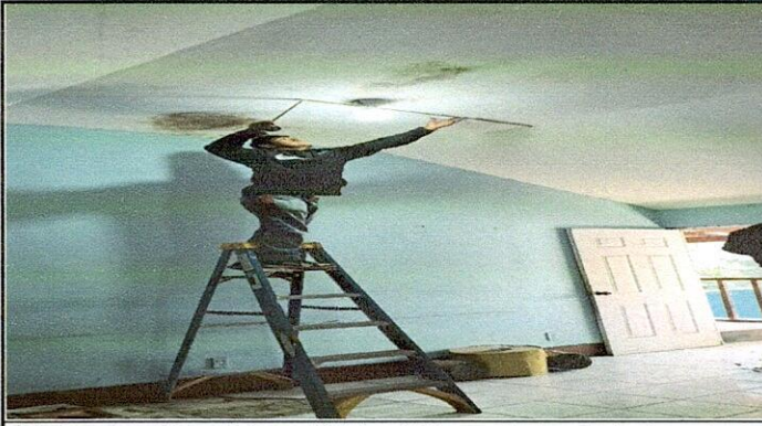
Foto 1: reparación a sistema eléctrico del tercer nivel. en todas las aulas
