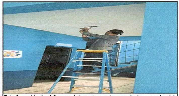
Foto 6: cambio de plafoneras interruptores y tomacorrientes en aulas del segundo y tercer nivel.
