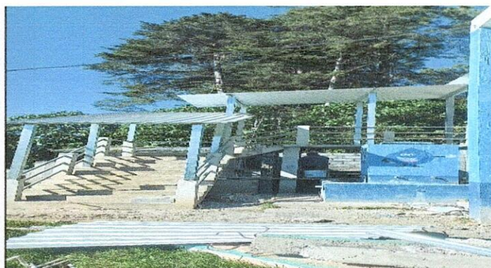
Foto 4: Estructura metálica sobre gradas.
