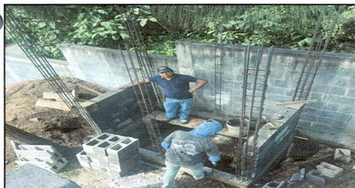
Foto 5: Levantado de muro para sanitarios.
