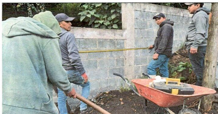
Foto 3: Preparan terreno para implementación de sanitarios.
