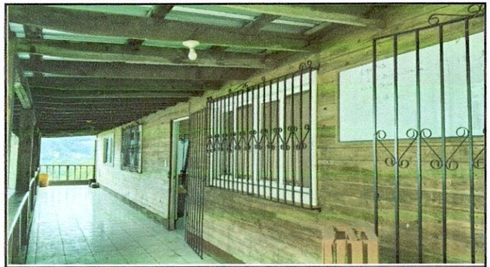
Foto 2: reparación a sistema eléctrico. En todas las aulas.
