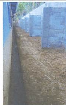
Foto 4: Culminación del muro de contención
