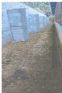
Foto 3: Culminación del muro de contención
