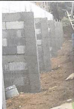
Foto1: Culminación del muro de contención
