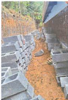
Foto 5: Reparación de muro de contención (levantado de pared)
