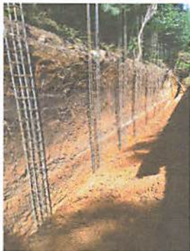
Foto 3: Reparación del muro de contención (columnas)
