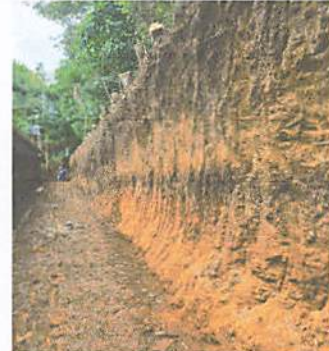
Foto 2: Reparación del muro de contención
