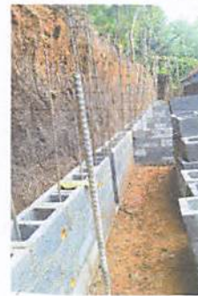
Foto 6: Reparación de muro de contención (levantado de pared)
