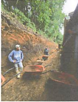
Foto1: Reparación de muro de contención (zanqueo)
