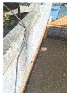
Foto 6: Esta pared del Segundo Nivel en el lado administrativo sera sernida con arena y cemento debido a la creacion de humedad que esto presenta es un total de 6 m de ancho por 3 m de alto.
