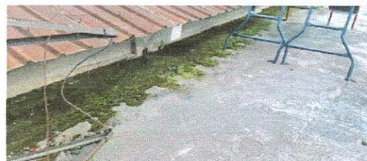
Foto 2: Se impermeabilizara el techo de terraza del segundo nivel debido a la filtracion de agua que se da en epoca de lluvia.
