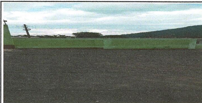
Foto1: Continuar el levanto de muro perimetral de metros 6 metros lado de la calle
