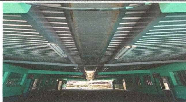
Foto 2: Cambio de lamina en dos aulas
