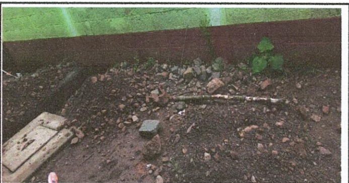
Foto 5: Renovar torta de cemento
