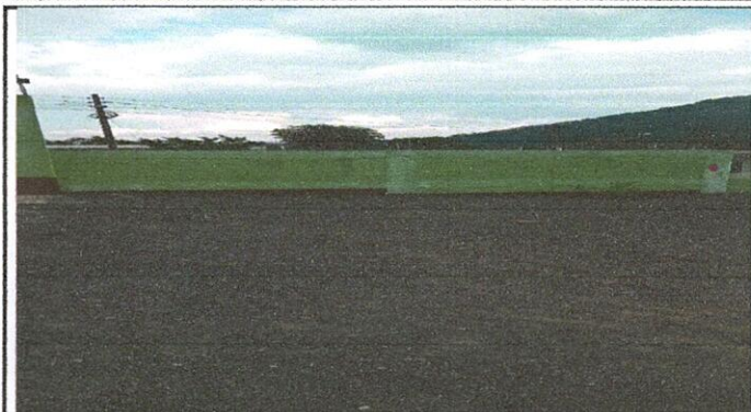
Foto 2: Continuar muro perimetral de 6 metros cuadrados
