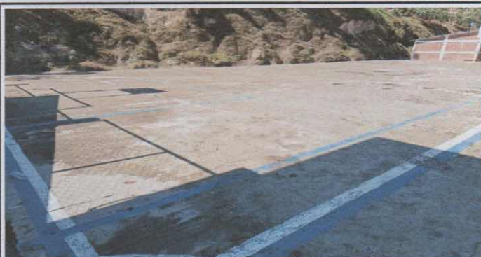
Foto1: Fotografía de la esquina noroeste del patio.
