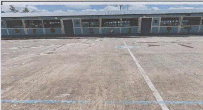
Foto 4: Fotografía del lado este del patio.
