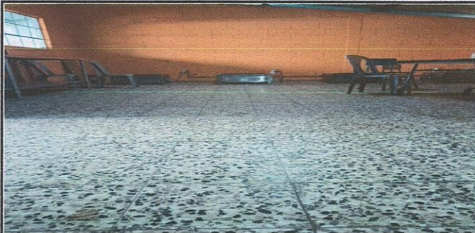
Foto1: Módulo de cocina en donde se colocaran las tres estructuras metálicas dos mesas y una estantería.
