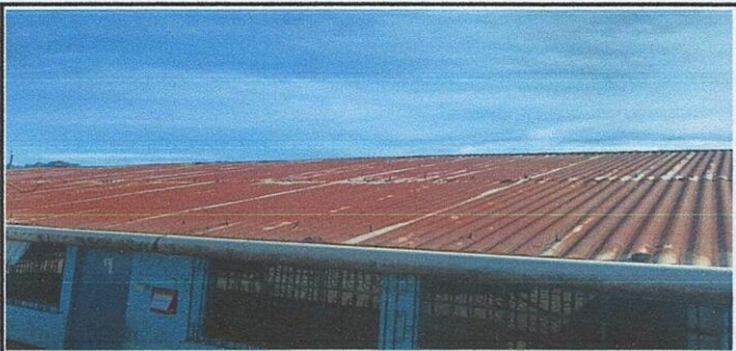
Foto 5: Cambio de techado de dos módulos de aula.
