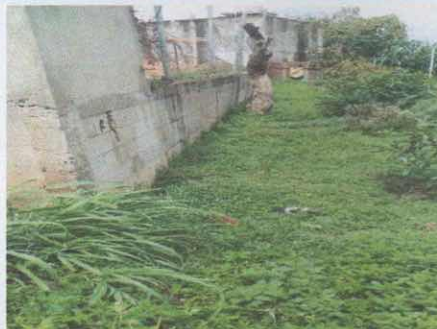
Foto 2: reparación de muro de contención para la seguridad de los alumnos
