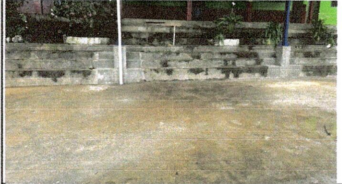
Foto 2: sustitucion base de concreto
