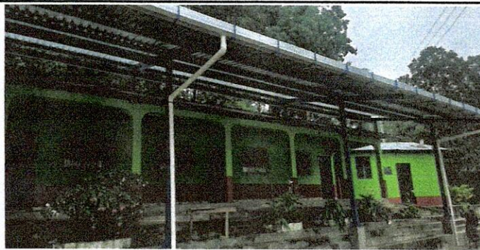
Foto 3: pintado suministro estructura metálica
