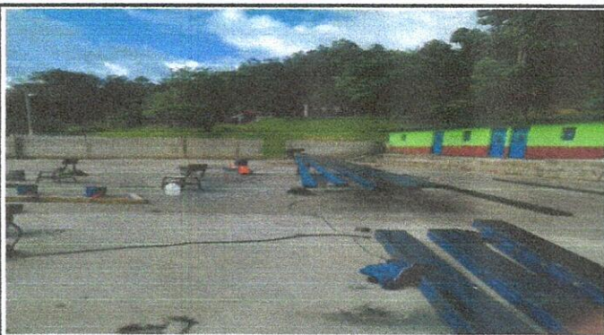
Foto 3: pintado suministro estructura metálica
