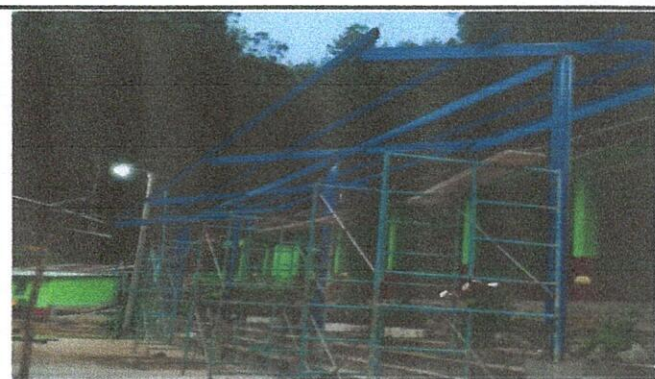
Foto 4: montaje estructura metálica
