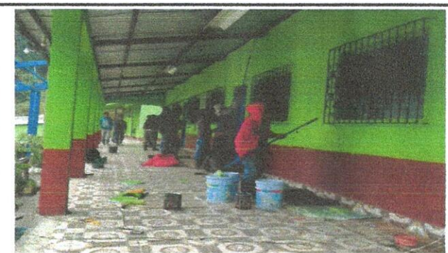
Foto 6: pintura de interior/exterior
