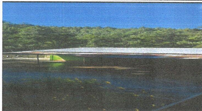
Foto 1: Sustitución de techado patio
