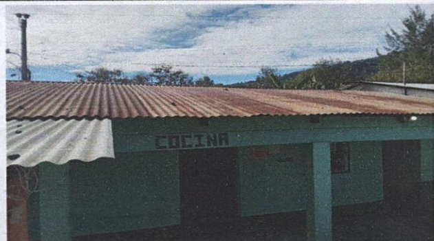
Foto 1: Sustitución de láminas, el techo de los salones en mal estado, evitar el goteo y mejorar el ambiente agradable para los estudiantes.
