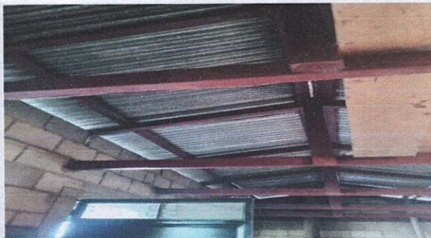
Foto 2: Estructura del techo de la cocinal y salones en mal estado, se necesita sustituir la madera por tubo galvanizado, para que tarda un largo tiempo el techo.
