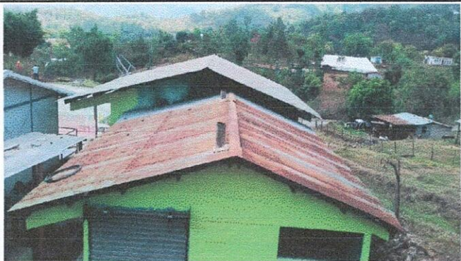
Sustitución de techo de cocina por deterioro
