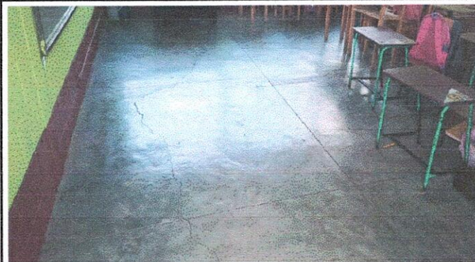
Sustitución de piso por rajado y deterioro.
